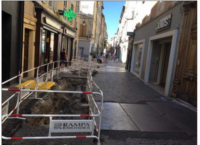
Des travaux sont réalisés en centre-ville. Actuellement, il s'agit de la phase concernant les réseaux (1,7 million d'euros). Viendra ensuite celle de l'embellissement (2,2 M€). La part communale est de 3 M€.
